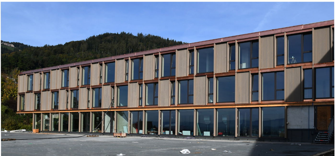
das neue Schulhausbau Friedbühl, nun bereits ohne Gerüst
