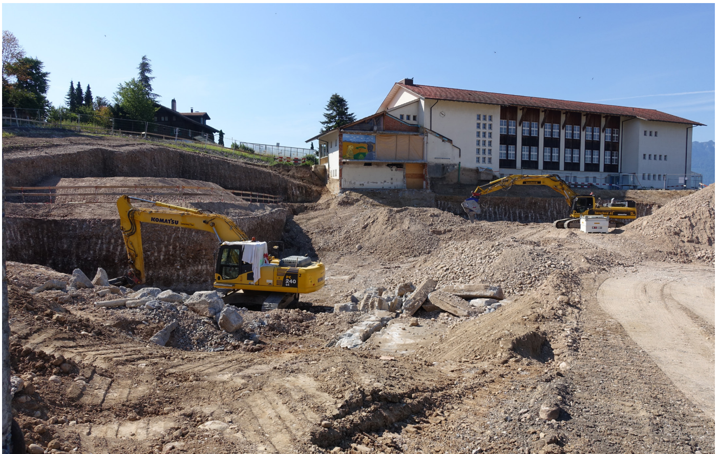
Nach den Abbrucharbeiten startete der Baugrubenaushub
