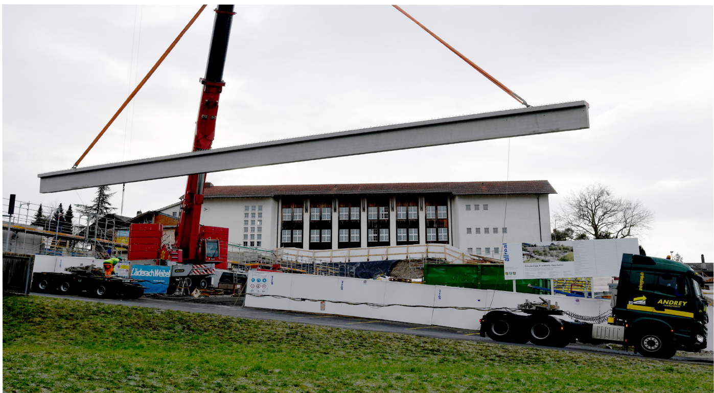
Ziel erreicht. Einer der 18 Stahlbetonträger kann abgeladen werden
