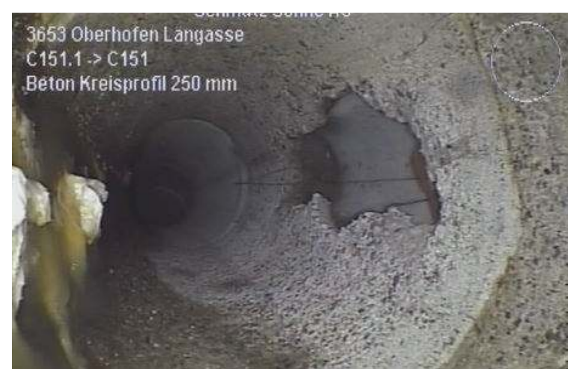
beschädigte Abwasserleitung
