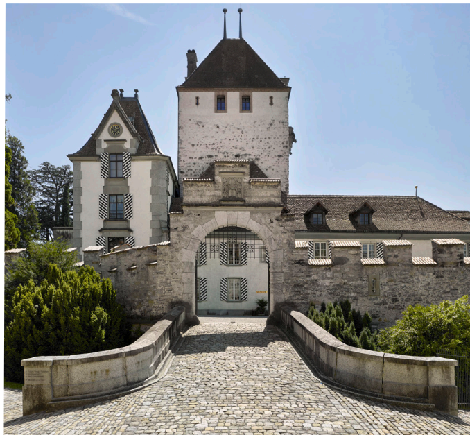
Die frisch restaurierte Turmuhr auf dem linken Turm
